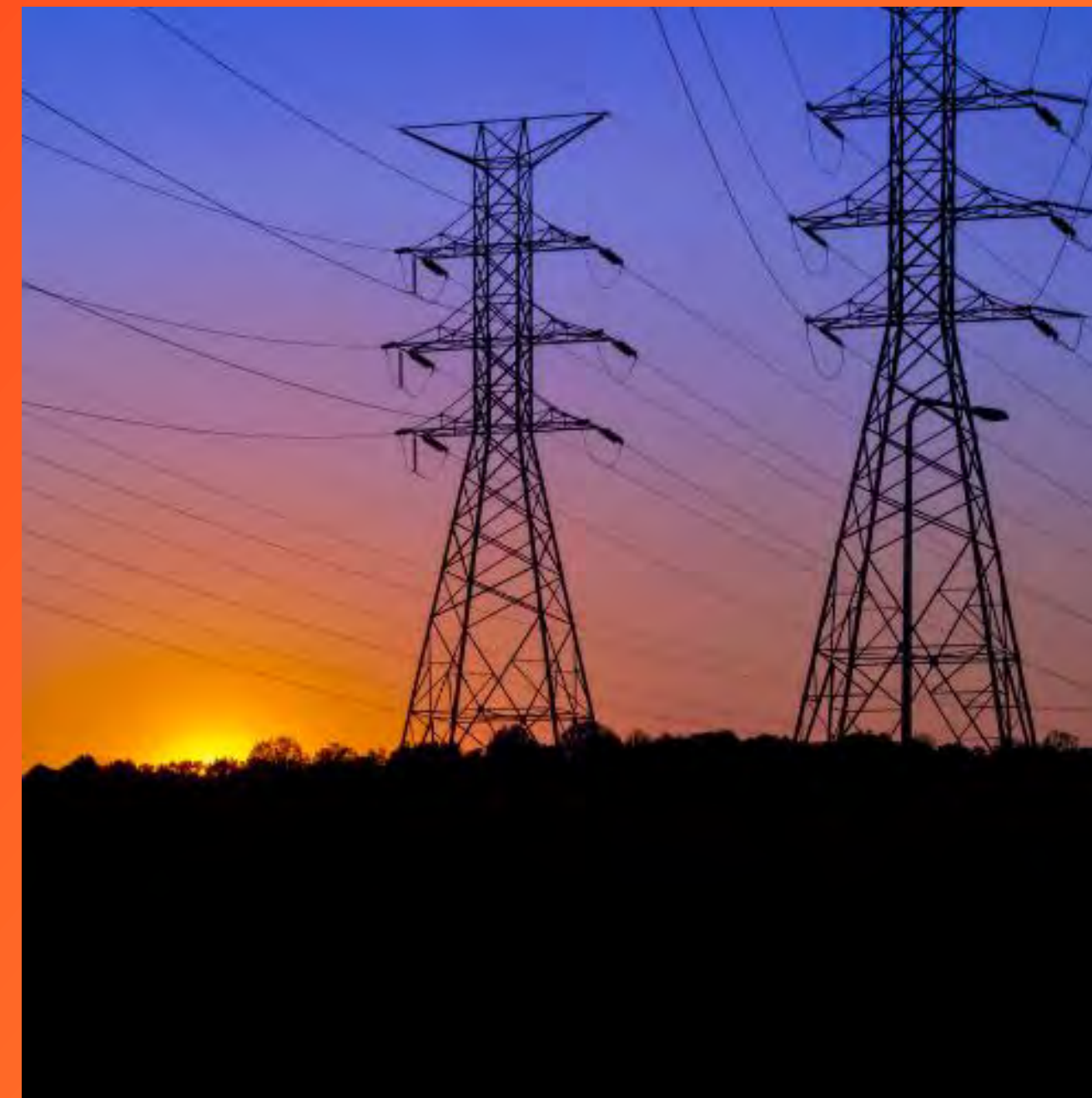
Contrat avec un opérateur réseau italien majeur 93 M€
