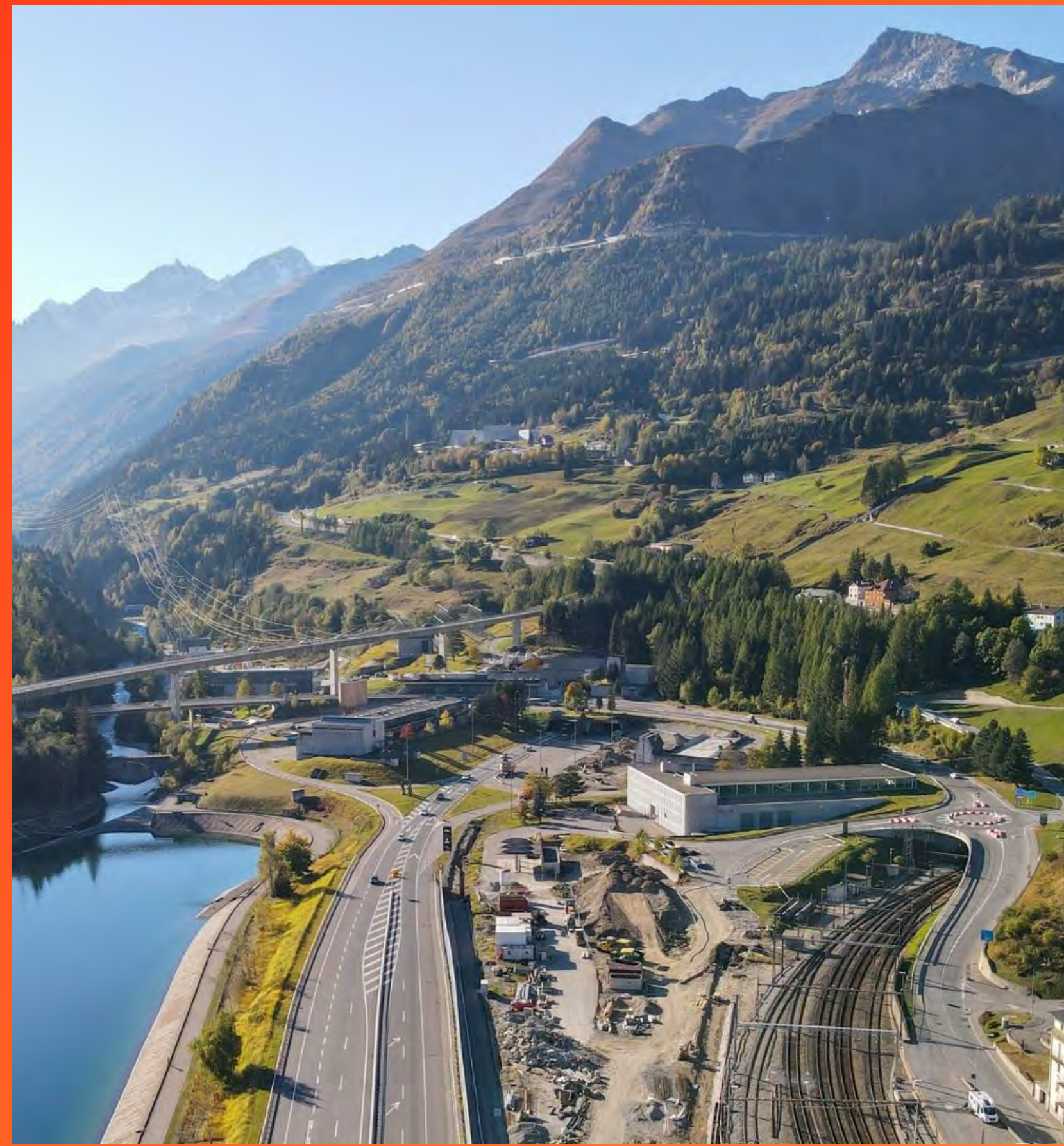
Contrat tunnel Saint-Gothard en Suisse
